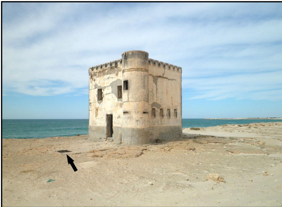
Lám. 9. Vista del fortín 4 junto al Atlántico, desde el sur. Con flecha, el aljibe (L. Blanco, 2012).
