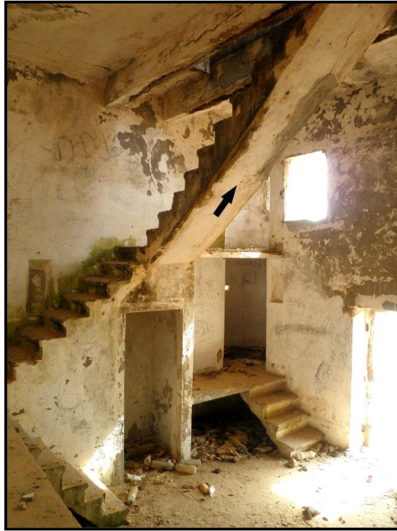
Lám. 10. Vista del interior del fortín 4, desde el norte. La flecha señala la escalera en voladizo hacia la terraza, y bajo su arranque, el espacio destinado a letrina (L. Blanco, 2012).
